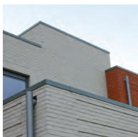
La rive spéciale pour couvertures de toitures en membranes d'étanchéité synthétiques jusqu'à 5 mm. L'étanchéité en tête est protégée et maintenue en place grâce aux striures prévues à cet effet. Trous oblongs pré-perçés en usine sur demande.
