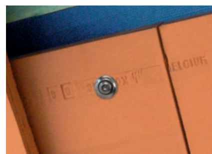
Vis Torx en inox avec anneau EPDM 4,5x35 mm pour les tuiles plates
