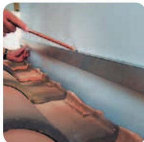
Après avoir soigneusement nettoyé les surfaces (tuiles et mur), découper, préformer et plier WAKAFLEX® à la bonne dimension. Enlever la bande centrale de protection.
