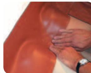
WAKAFLEX® peut également être utilisé pour réaliser esthétiquement un chéneau latéral encastré ou une pose en noquet.
